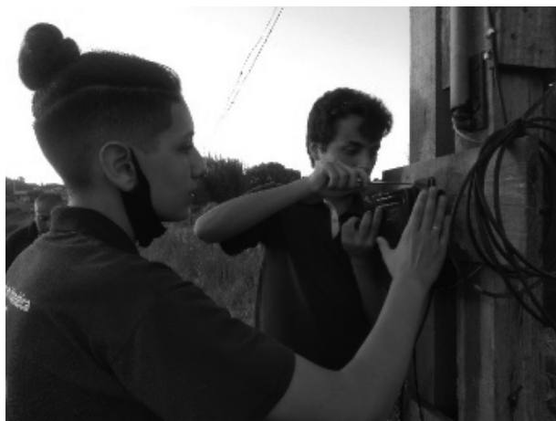
Figura 17 — Fixando a caixa hermética no poste
