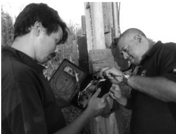
Figura 16 — Instalação do cabo de energia
